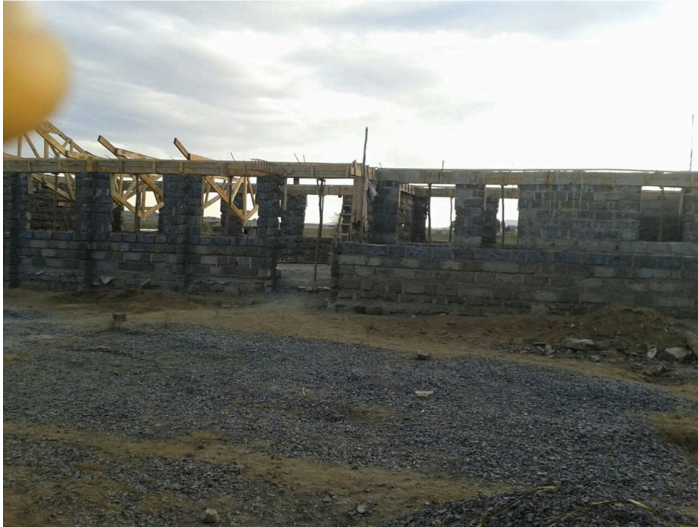
3) Rohbau des Speisesaal-Gebäudes (mit Küche und Lagerräumen)
