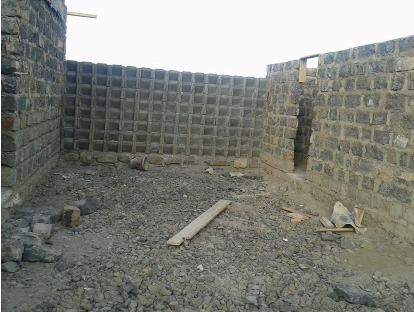
4) Innenansicht des noch unfertigen Innenhofs des Schlafsaal-Gebäudes. Die Tür rechts führt zu den Nassräumen
