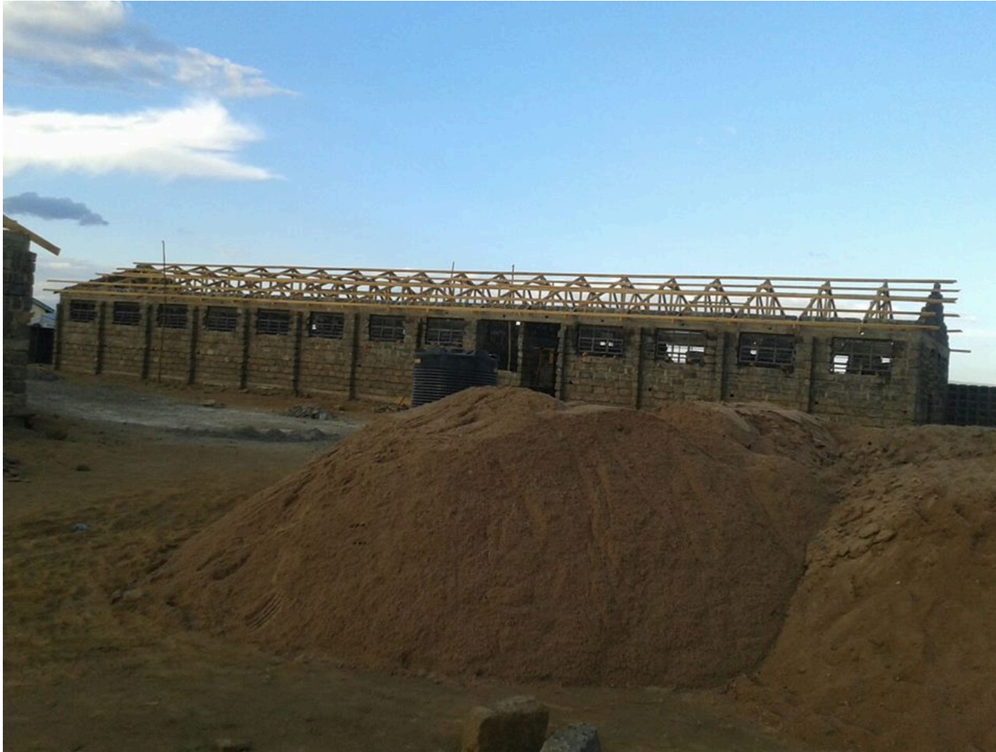
1) Rohbau des Mädchen-Schlafsaal-Gebäudes und der Wohnung für die Aufsicht mit Dachstuhl
