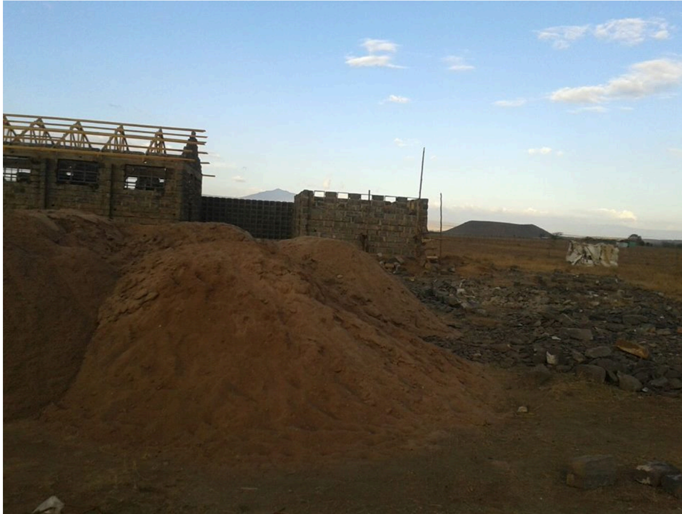
2) Dito. Rechts der Innenhof und die Nassräume, die beide noch keinen Dachstuhl tragen
